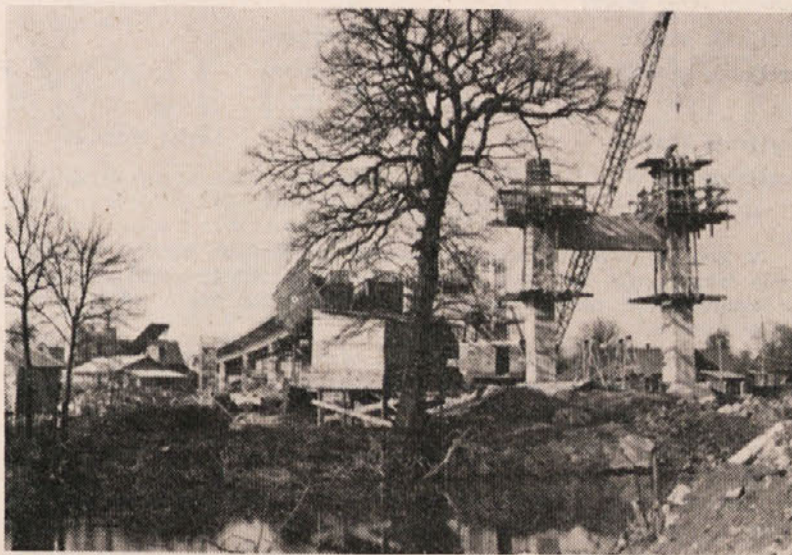
Montaža opaža stebra. V ozadju se vidi pomični opaž prekladne konstrukcije in štiri zabetonirana polja.
