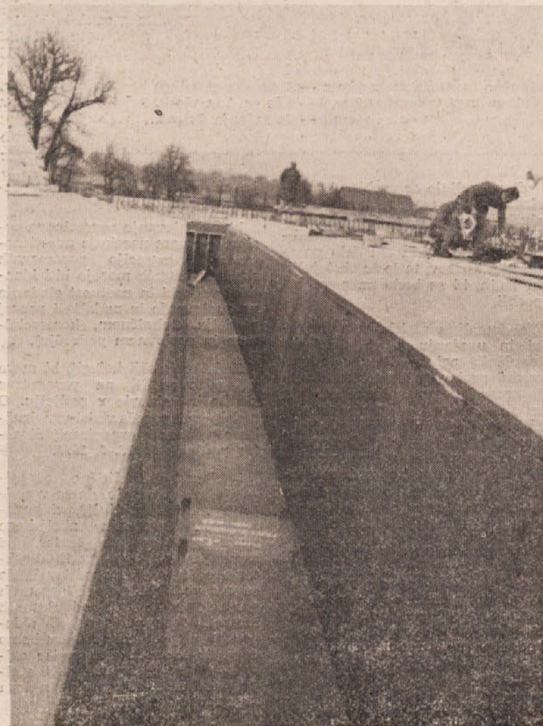
Pomična opažna konstrukcija med izvajanjem severne polovice viadukta (vozna smer Ljubljana-Postojna)
