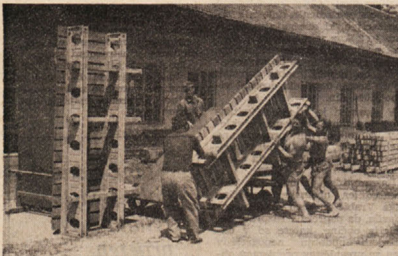
Izdelava montažnega opaža za stebre na Gomilskem.
