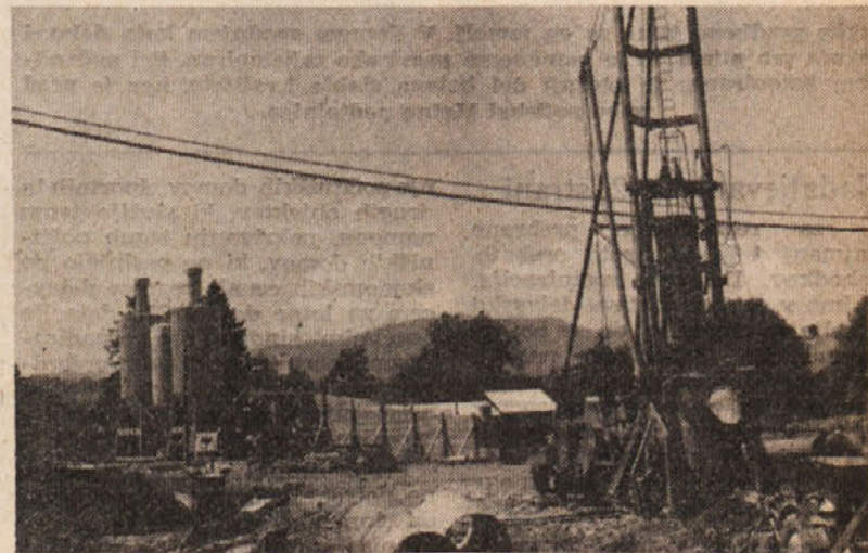
Pogled na stroj Benoto med vrtanjem pilotov in na eno betonarno. Gradbišče ima namreč dve betonarni s skupno kapaciteto 30 m³ na uro in možnostjo uskladiščenja 200 t cementa v silosih.
