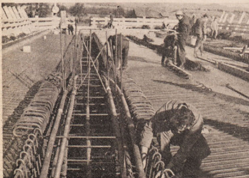
Polaganje kablov v nosilca. V vsak nosilec se položi 11 kablov in to na točno določeno mesto, kajti dopustne tolerance so zelo majhne, največ 5 mm!
