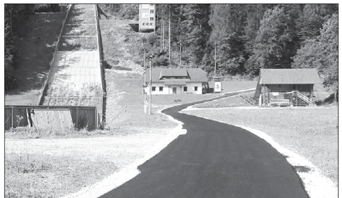
Nova asfaltna prevleka ceste v Savini pri skalalnici (Fotodokumentacija Občine Ljubno)
