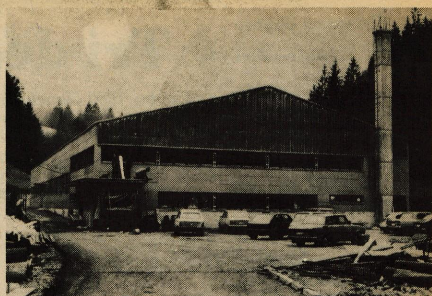
...novo moderno Termopolovo proizvodno dvorano na spodnjem koncu Sovodnja
