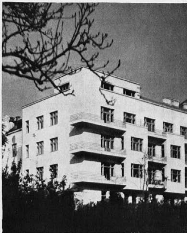
Izgled Vue générale
