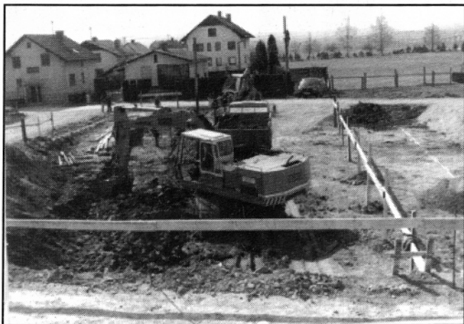
Delo na šolskem gradbišču 1. aprila (foto: Ciril Sem)
