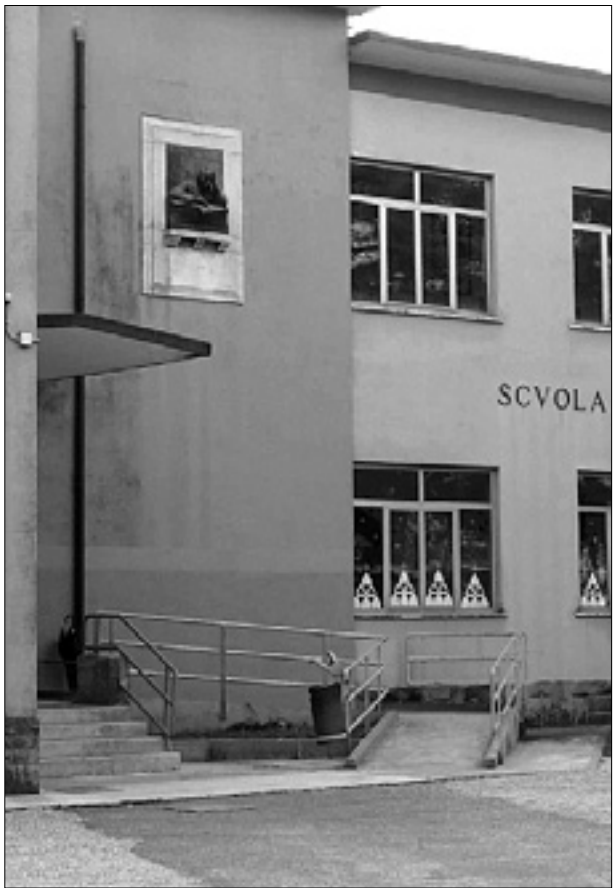
Šolska stavba v Bračanu, kamor sta namenjena slovenski vrtec in osnovna šola
