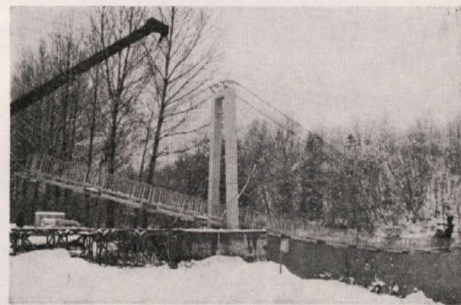
Montaža se začne... s pomočjo avtodvigala in strojnega vitla je most obešen na vrvi počasni drsel
