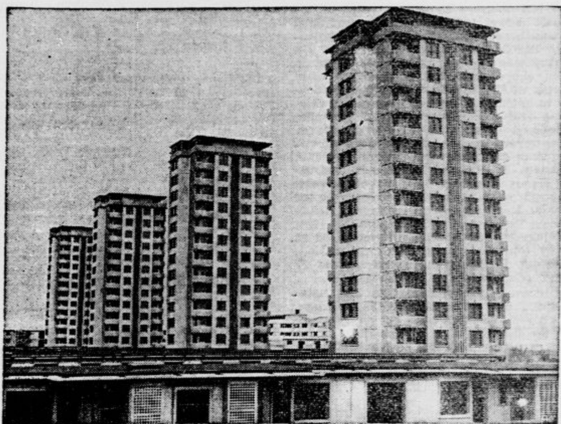
V Drancyju blizu Pariza so zgradili serijo stanovanjskih hiš, ki so prav čedni nebotičniki. Visoki so 55 m. Ogrodje hiš je iz jekla, zidovi pa iz železnega betona
