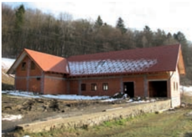
Nov župnijski dom v gradnji (foto: D. Krpič)
