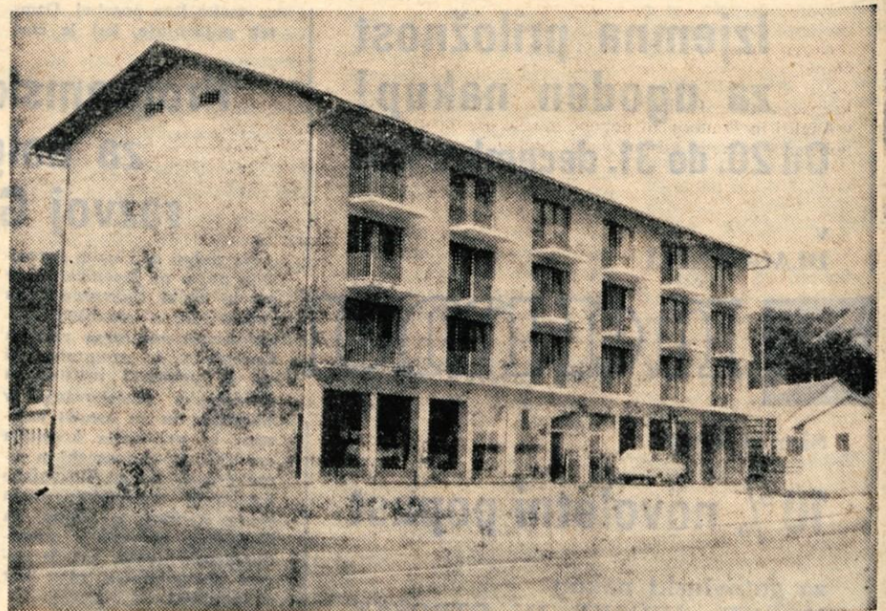
Stanovanjski blok v Kamniku
