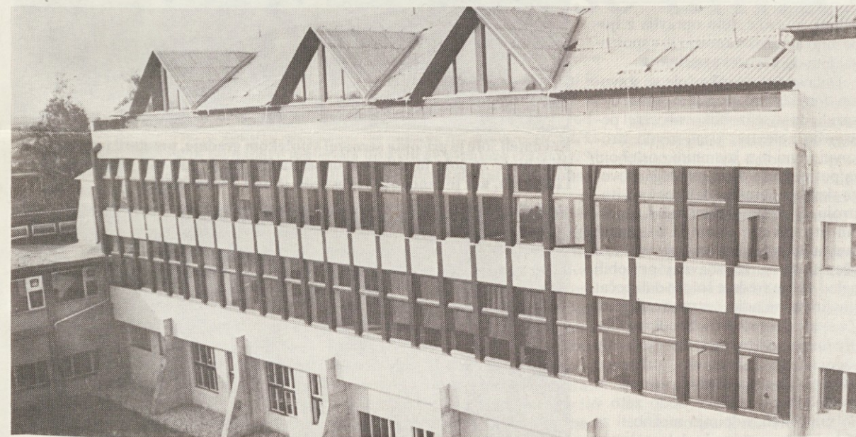
Nova zgradba se lepo in funkcionalno vključuje v dosedanje šolske objekte (Foto: T. Š.)
