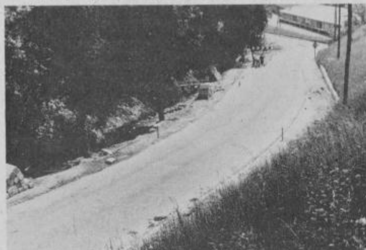
Obnova in širitev Kolodvorske ulice v Ormožu.
