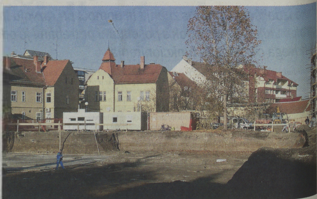
Gradbena jama za stanovanja v Cvetkovi ulici, ki jih gradi Imo-Real, bo kmalu izkopana. Stanovanja pa bodo vseljena v drugi polovici prihodnjega leta. Foto: M. H.
