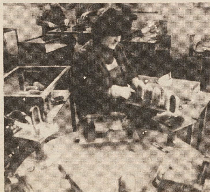
Stroj za mehko spajkanje. Vrtljiva miza je Iskrin izdelek, avtomatiko pa je naredil mariborski Zavod za varjenje.
