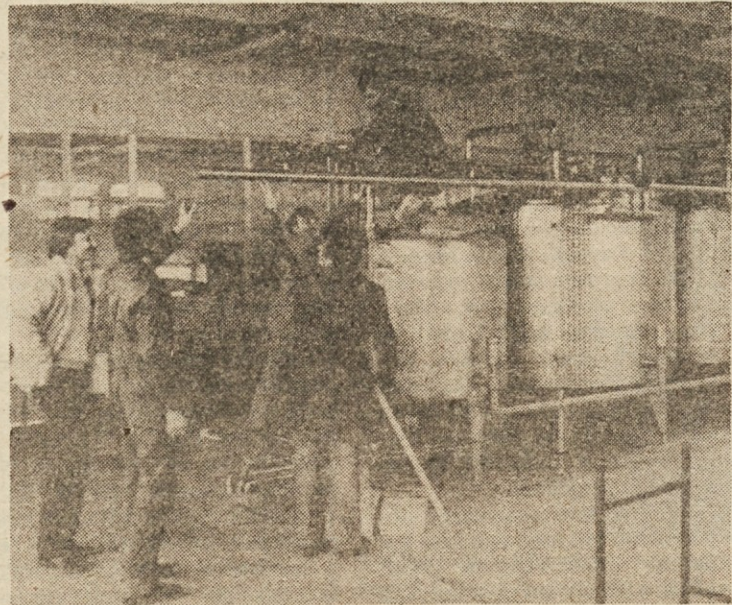
Montaža postaje za kemično čiščenje v Mlekarni Ljubljana.
