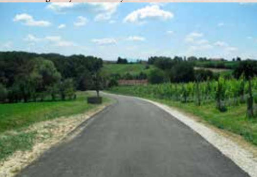
Modernizacija ceste Jastrepci
