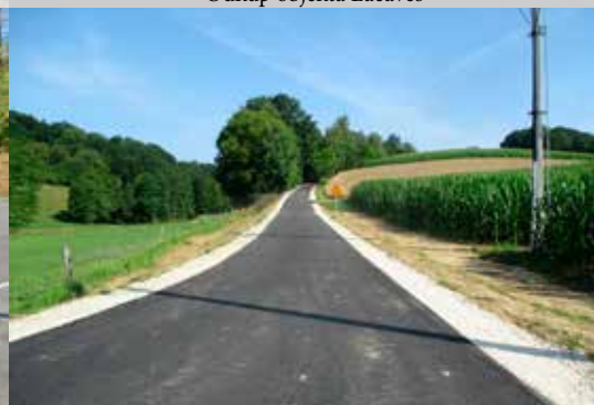
Preplastitev in delna širitev ceste Veličane - Cerovec
