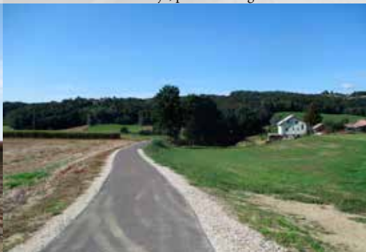
Modernizacija ceste Lešnica
