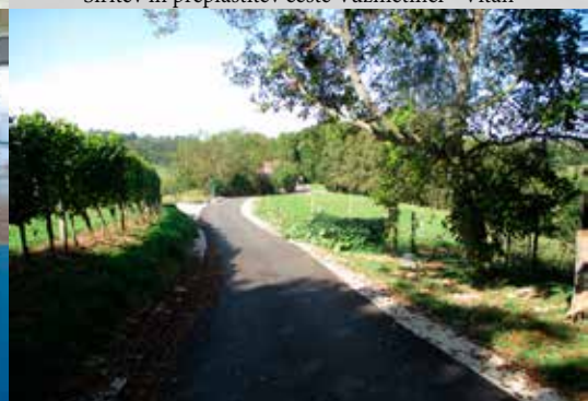
Modernizacija ceste Stanovno
