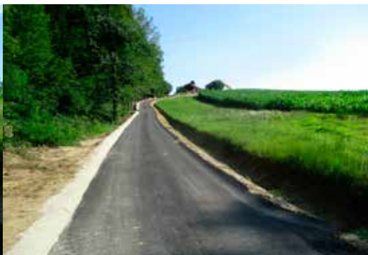
Modernizacija ceste Litmerk
