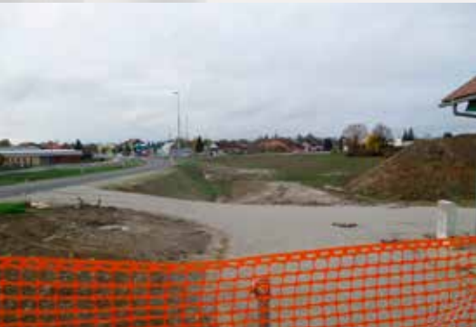
Izgradnja kanalizacije v OC Ormož-sever
