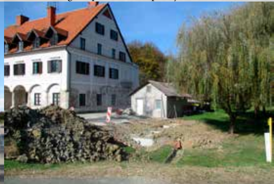
Izgradnja male čistilne naprave Pušenci
