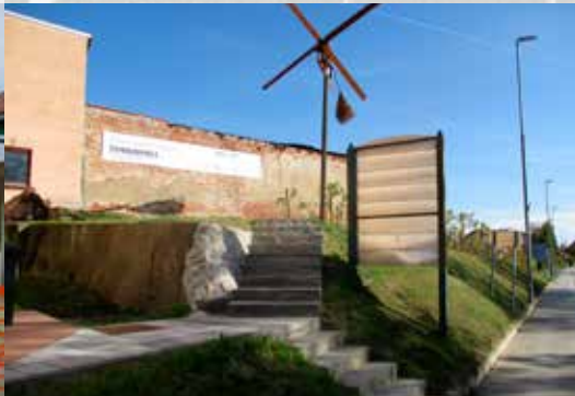
Izgradnja stopnišča in podesta pri mestnem vinogradu
