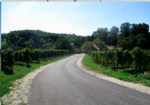
Preplastitev ceste Mali Brebrovnik
