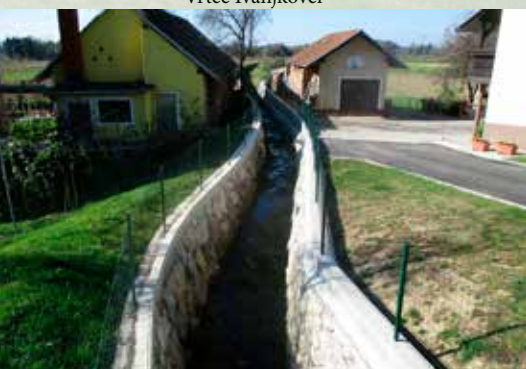
Sanacija jarka Mihovci
