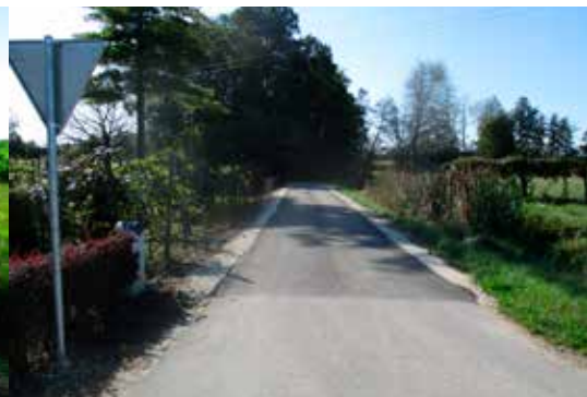
Modernizacija ceste Mihovci
