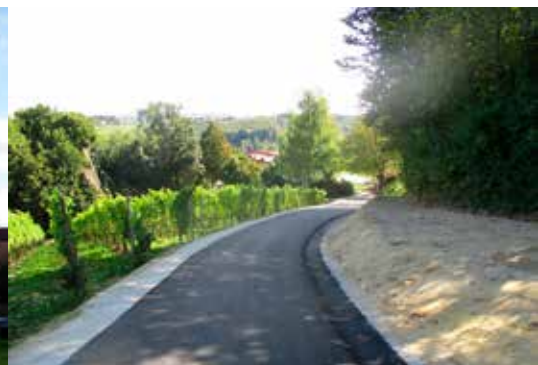
Modernizacija ceste Runeč
