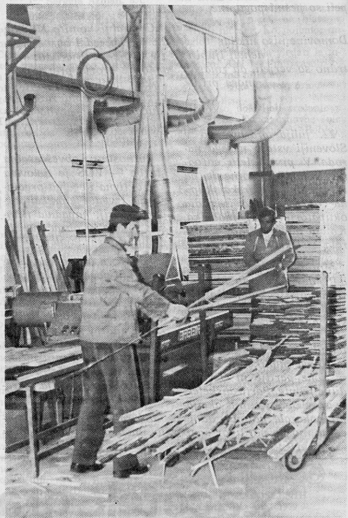
Kar pri paranju lesa za pohištvo le-tega odpade, se ta uporablja za izdelavo srednjega sloja za opažne plošče.
