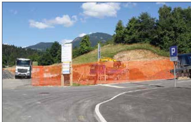
Delavci trenutno delajo izkop, da bodo lahko začeli z betoniranjem temeljev in nadaljevali z gradnjo. (Foto: BK)
