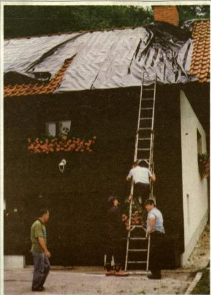
V občini Podčetrtek je akcija civilne zaščite in gasilcev stekla takoj po neurju. Najprej je bilo treba prekriti poškodovane dele na strehah.
