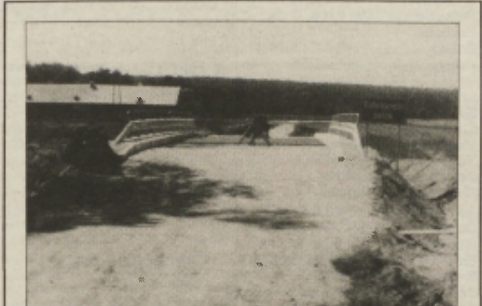
MOST - V občini Lendava ta čas gradijo mostova čez potoka Čebiš in Kobiljanski potok. Oba financira državna uprava za ceste, gradijo pa ju delavci Ingrad iz Celja. Po dograditvi bodo še obnovili cesto Kobilje-državna meja, dolgo 4.200 metrov, in tako bo, kar zadeva ceste in mostove, vse pripravljeno na odprje mejnega prehoda z Madžarsko. - Fotografija: J. Ž.
