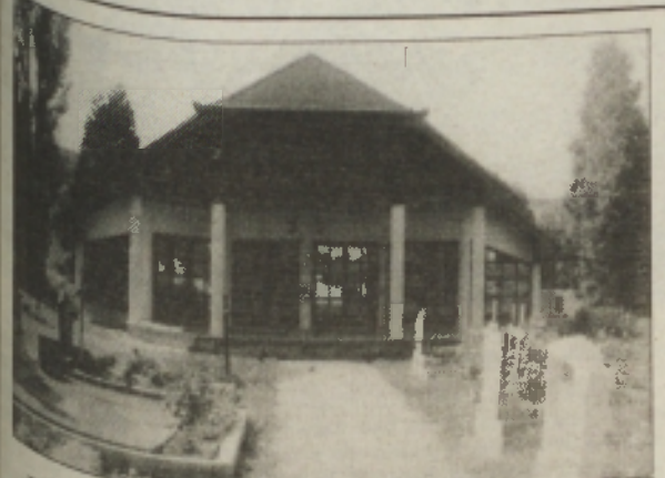
VEŽICA - Na Kobilju so dogradili mrliško vežico, ki ima prostora za dva pokojnika, sobo za žalujoče, kuhinjo in wc. Načrt je naredil Vajda inženiring iz Lendave, vežico je postavil Vajda inženiring in kooperanti. Vrednost je okrog 5.000.000 tolarjev. Denar so zbirali s kradnjo samoprispevkom, pomagali pa so še z delom. Ob dnevni mrtvih bo vežico blagoslovil domač župnik Franc Hales. - Fotografija: J. Ž.
