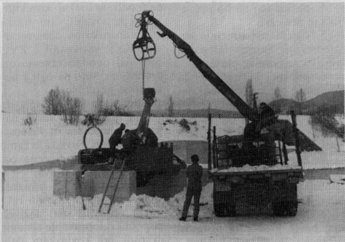
Montaža lupilnega stroja na mehaniziranem lesnem skladišču Bled-Rečica (foto Ažman)
