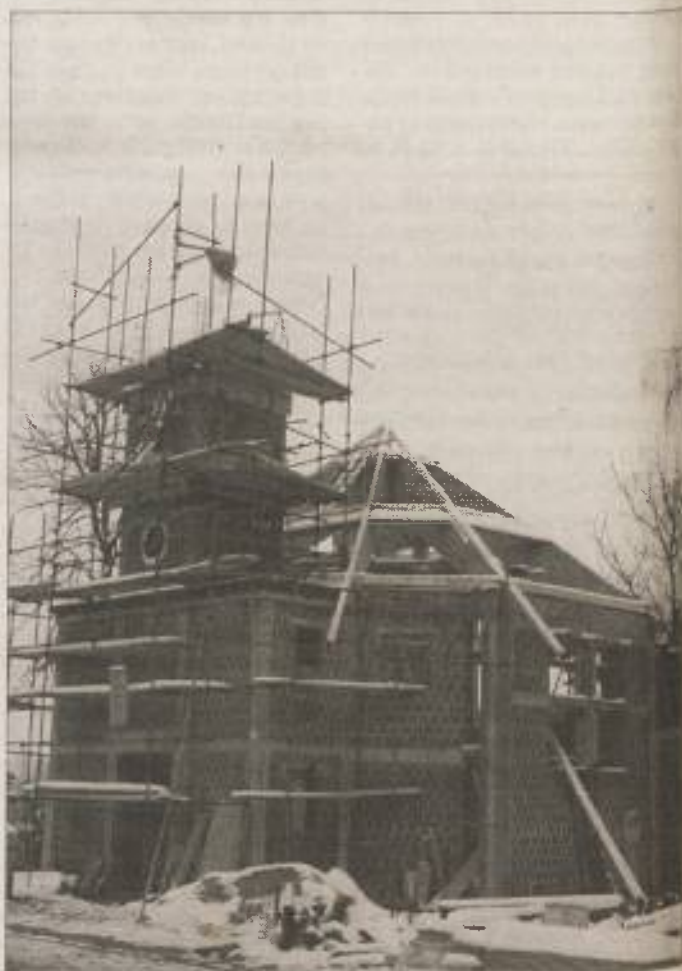
Delavci gradbeništva Šumenjak so hiteli in v Gaberju, še preden je zapadel sneg, sezidali kapelico, za katero je načrte naredil dipl. inž. Jozef Kovač. - Fotografija: Simonka
