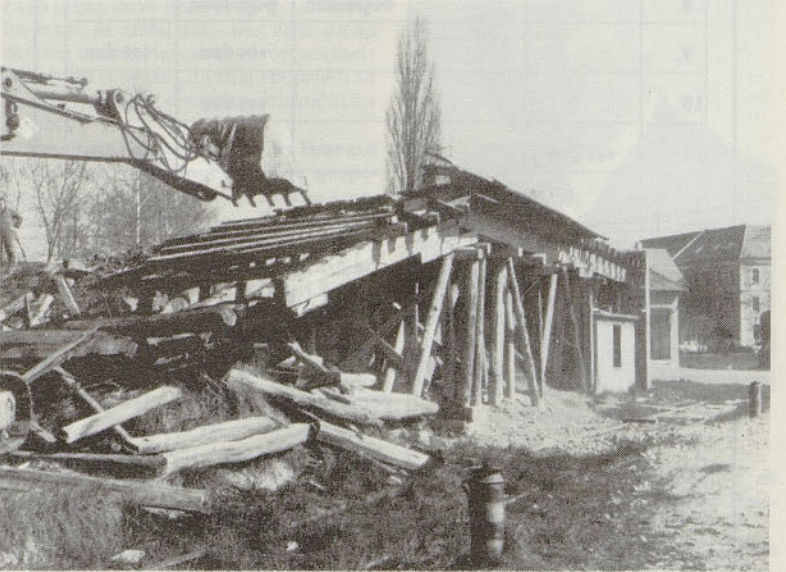
Strojna, TOZD Games bo zgradil v Žalcu novo vzvišeno nakladišče na mestu dotrajanega.
