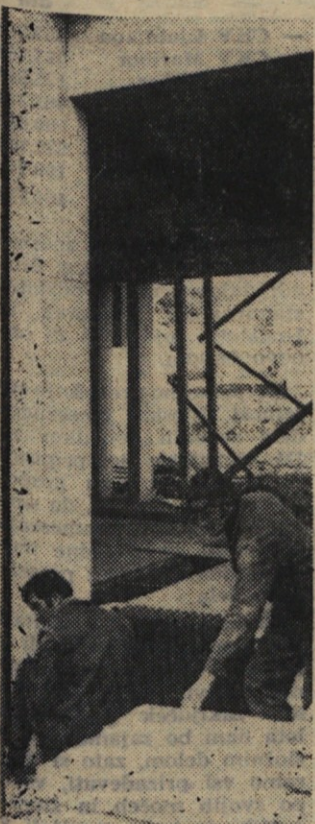
Sten še ni radiatorji že stojel!
