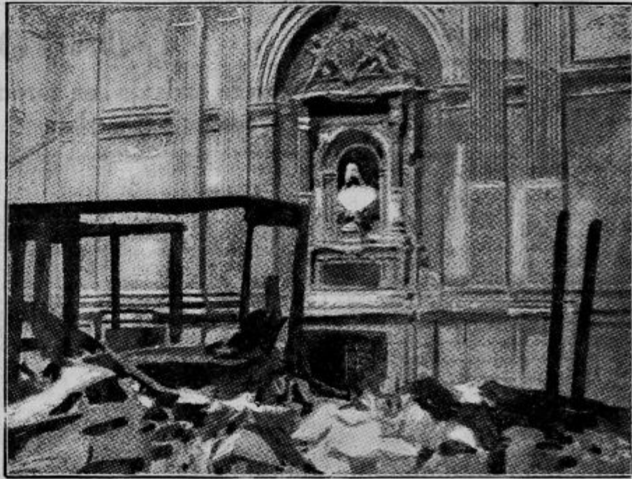
Marmorna dvorana v II. nadstropju justične palače po požaru
