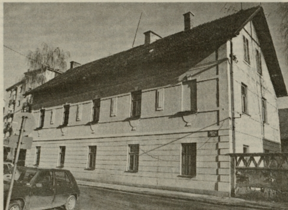
Hiša na Ipavčevi 12. Fasada je sicer obnovljena, znotraj pa marsikaj škriplje.
