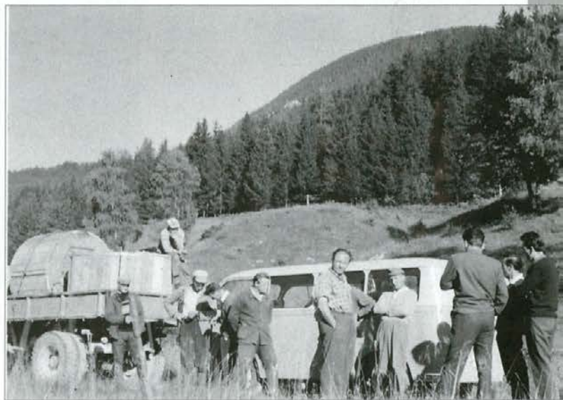
Delavci Elektro Slovenj Gradec priprava za razlaganje
