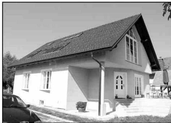
Pri prenovah starejših hiš smo pogosto omejeni z velikostjo steklenih površin, vsaj na fasadi.
