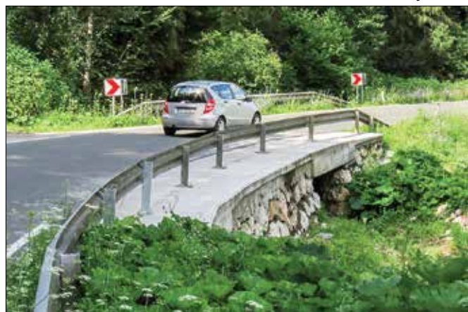
Obojestranska podporni zidova regionalne ceste v Spodnjih Krašah sta na novo utrjena. (Foto: Igor Solar)
