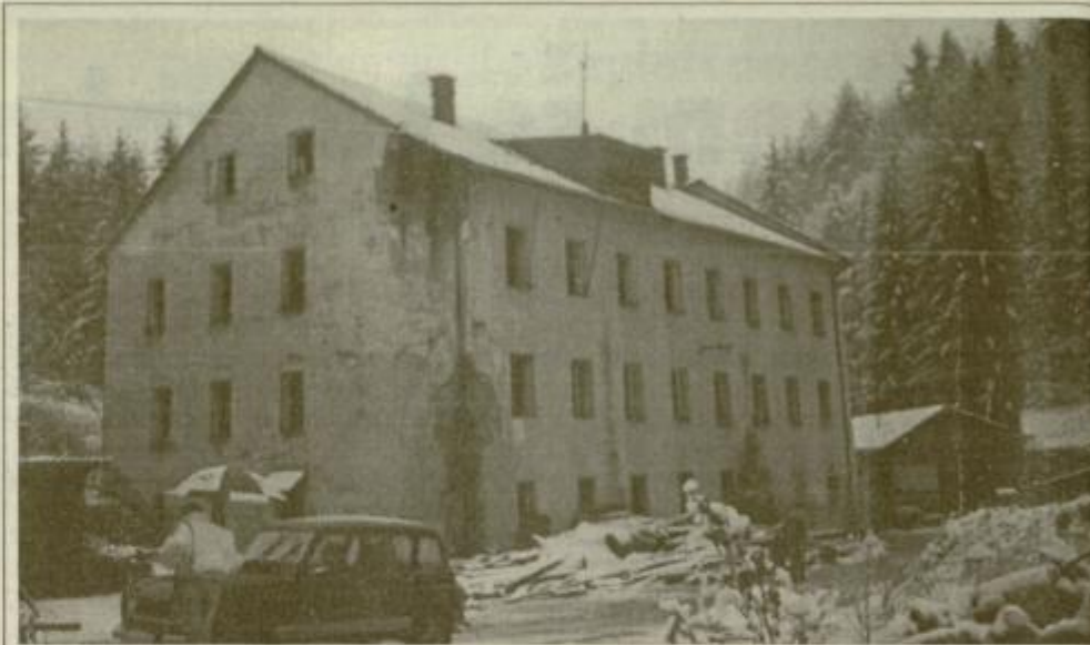
Že šibak potres je dovolj in zgradba se bo sesula na cesto.
