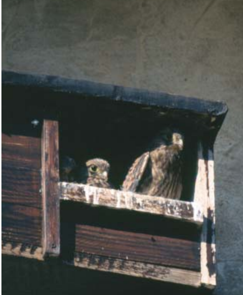
Mlade postovke bodo kmalu zapustile varno zavetišče na transformatorju.
