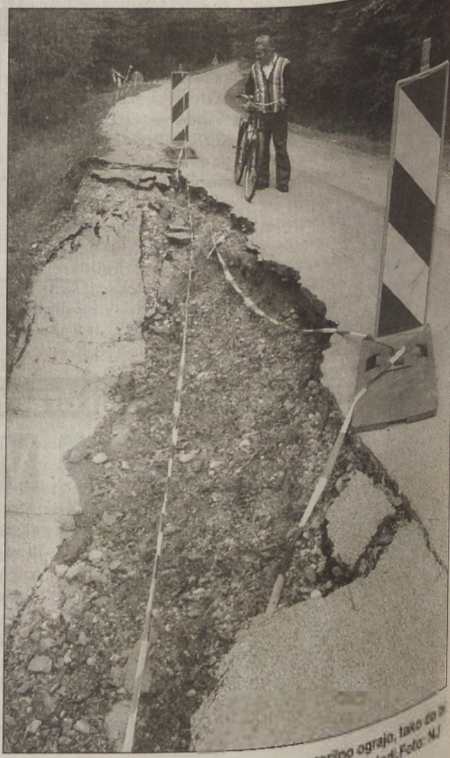
Cesta bo sanirana s cevmi in zasipom ter opozorilno ograjo, tako da jo morala vzdržati čez zimo. Nadaljevanje bo sledilo spomladi. Foto: M.
