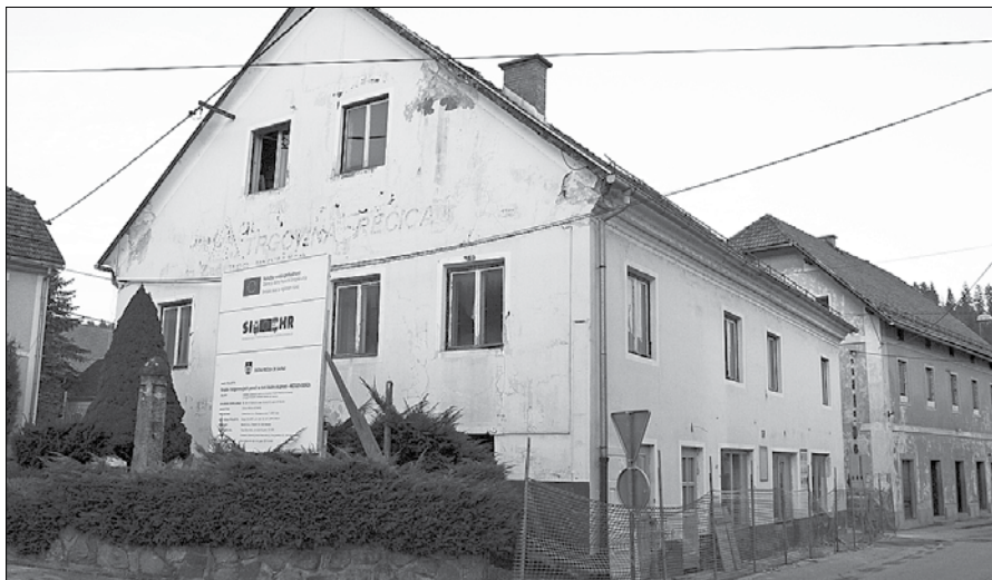
Občina Rečica ob Savinji je že začela z investicijo obnove objekta, ki je namenjen medgeneracijskemu druženju, sledi še nakup opreme in nato izvajanje vsebin. (Foto: Marija Lebar)
