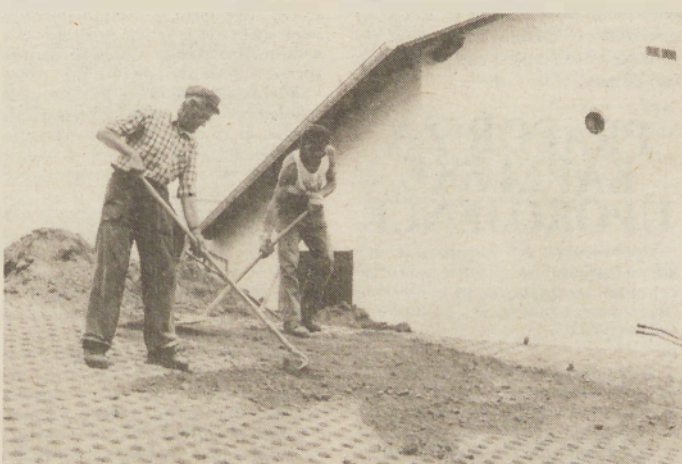
UREJANJE OKOLICE — Delavci Splošnega gradbenega podjetja Pomurje iz Murske Soboti so med našim obiskom urejali okolico novega črpališča. Foto: M. Jerše.
