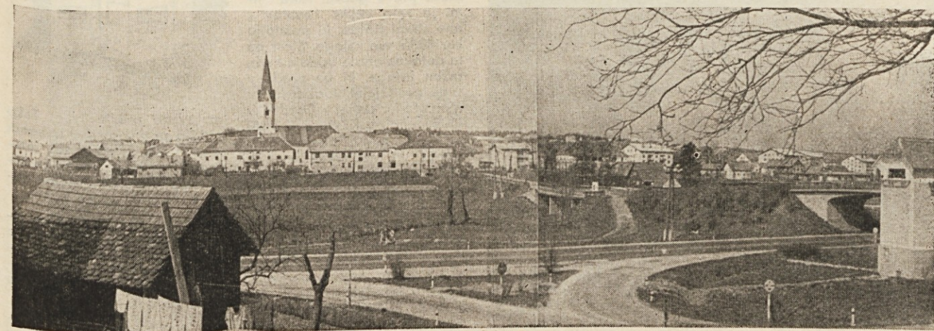
Trebnje na Dolenjskem se vedno bolj širi in modernizira. Na sliki pogled z avtomobilske ceste
