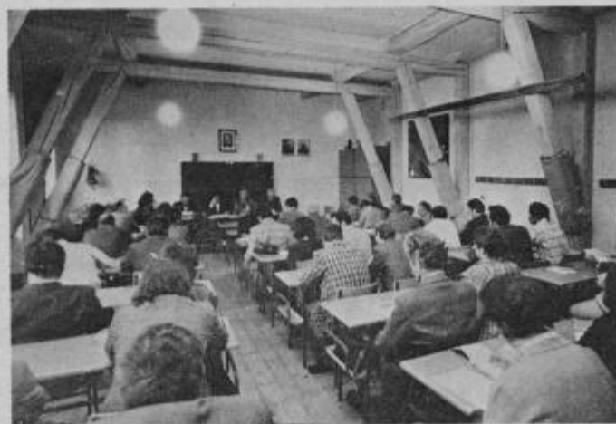
S tramovi podprti stropi v osnovni šoli bratov Štrafela v Markovcih.
