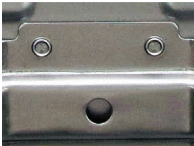
» Zveza pločevin z okroglima točkovnima spojem Tox
