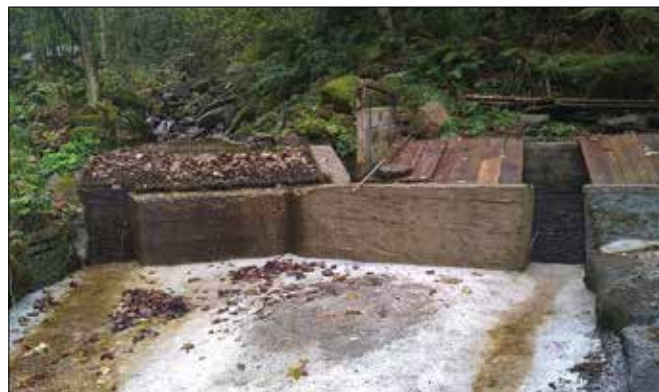
Mesto zabetoniranega zajetja, kjer je vidno, da preko desk gre le še kaka kapljica vode.
