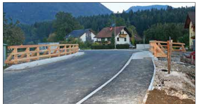
Z novim mostom je poskrbljeno za večjo pretočnost prometa in za izboljšano poplavno varnost. (Foto: Marija Lebar)
