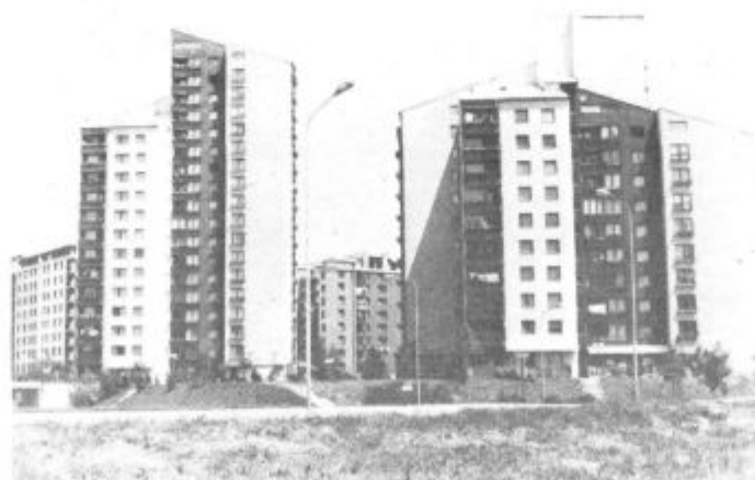
Pričakovali bi, da v novi stanovanjski soseski, zgrajeni po sodobnih projektih, ni komunalnih težav, pa žal ni tako.
