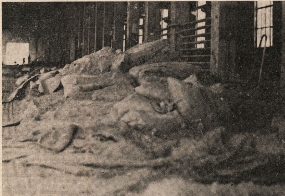
Klasičen primer kako se ne sme vskladiščiti material, nam kaže ta slika. Razmetane in raztrgane vreče cementa v proizvodni hali v Medlogu, se smejiijo v brk vsem prizadevanjem, da bi se napravil red vskladiščenja tistega materiala, kjer je to mogoče.
