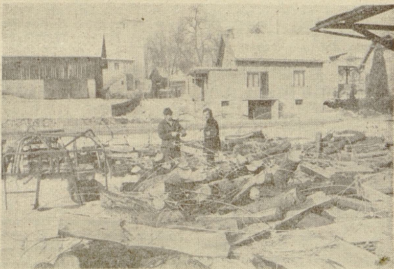
Vso zimo se hmeljarji pripravljajo za gradnjo novih žičnic. Na Polzeli pripravljajo sidra.
