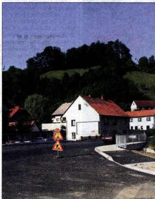
Pred glavnim križiščem v Rogatcu so naprej zgradili nov most čez Drganjo. Tuži druga dela so v glavnem že zaključena.
