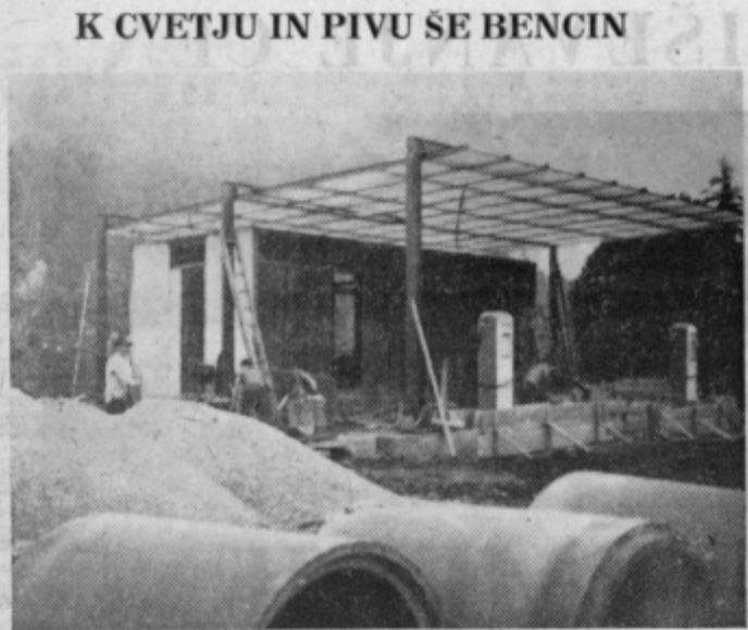
Gradbena dela pri gradnji bencinske črpalke v Laškem lepo napredujejo. Železna konstrukcija upravnih prostorov je že pod streho, izvršena pa je že tudi montaža črpalke. Gradbena dela
