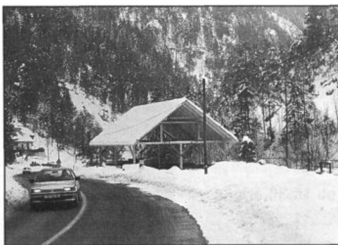
Dograjena in obnovljena vodna elektrarna med cesto in Savinjo krajevni skupnosti ne bo več v sramoto
