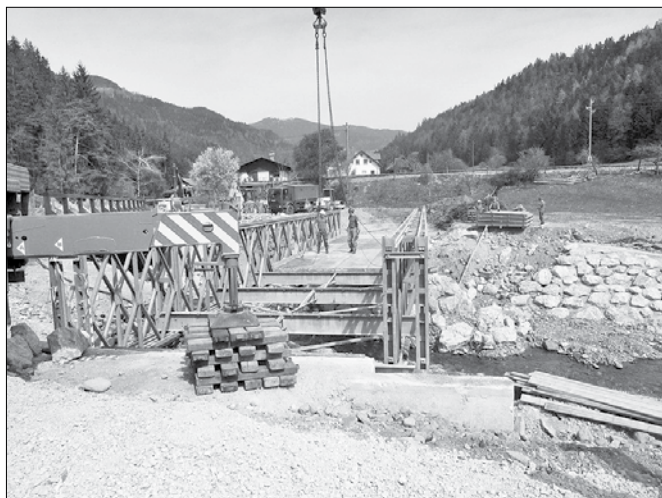
Pripadniki Slovenske vojske pri demontaži mostu. (Foto: ML)
