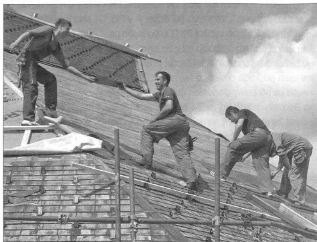
Pravilno in strokovno izvajanje del pri vzdrževanju streh, fasad, napuščev in drugih delih na višini je zelo pomembno (foto: IS)
