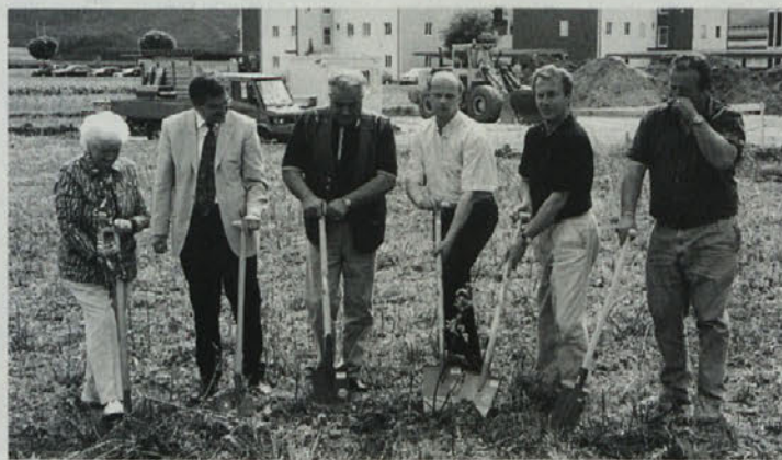
V ponedeljek so položili temelje za nova stanovanja v Šmihelu
