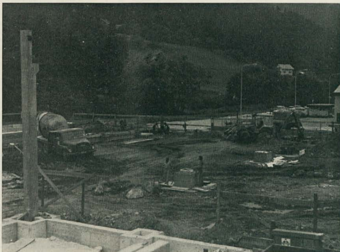
Začetek gradnje nove proizvodne hale — prvi stebel
