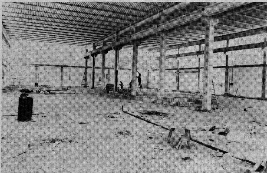
Notranjost Gradbenikove proizvodne hale med gradnjo
