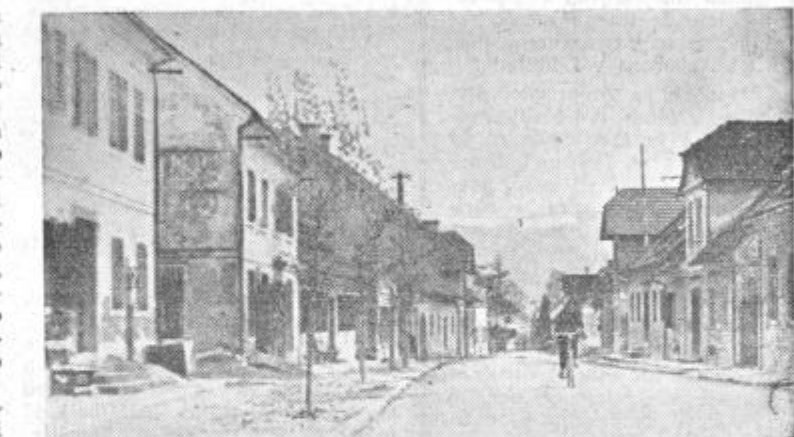
Skozi Braslovče so letos asfaltirali cesto. Za vselej so rešeni nadležnega prahu po zaslugi kmetijske zadruga, katere skrb ni samo kmetijska proizvodnja, temveč tudi kulturni in komunalni napredek podeželja.
