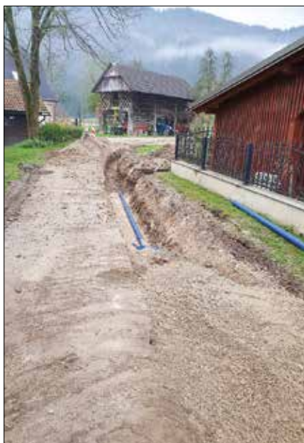
Za izvedbo del na vodovodih je bilo potrebno prekopati obe cesti skozi vas.
