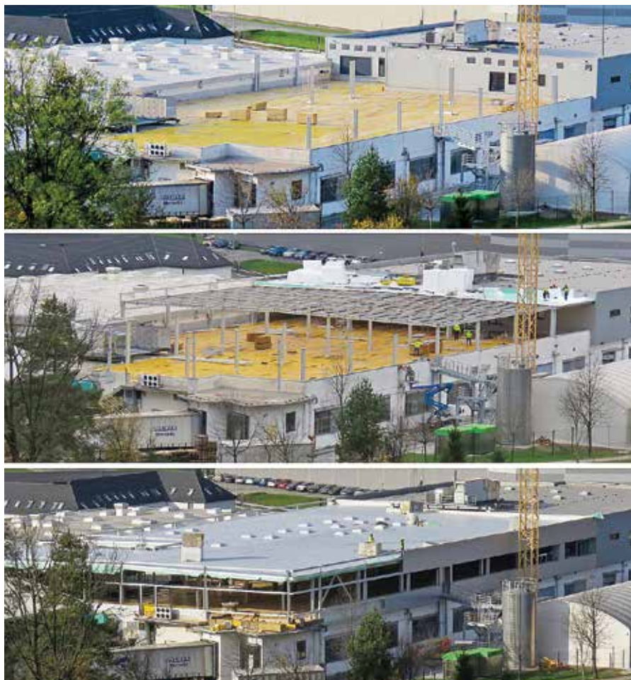
Gradnja novega razvojnega centra, ki ga postavljajo nad proizvodno halo BSH Hišni aparati Nazarje, vidno napreduje. (Foto: IS)
